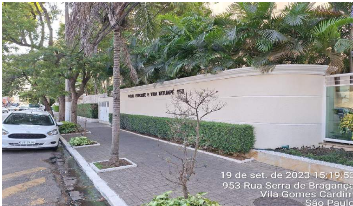
Foto 2 – Fachada frontal do condomínio
