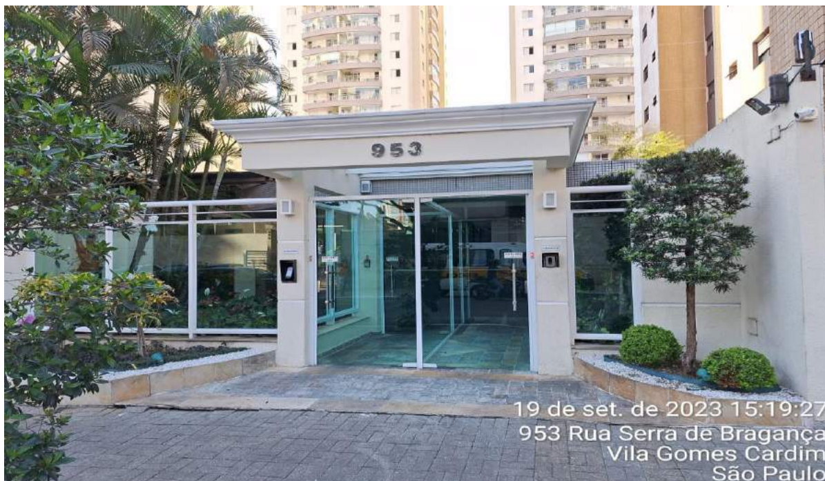
Foto 1 – Portaria principal – lado externo
