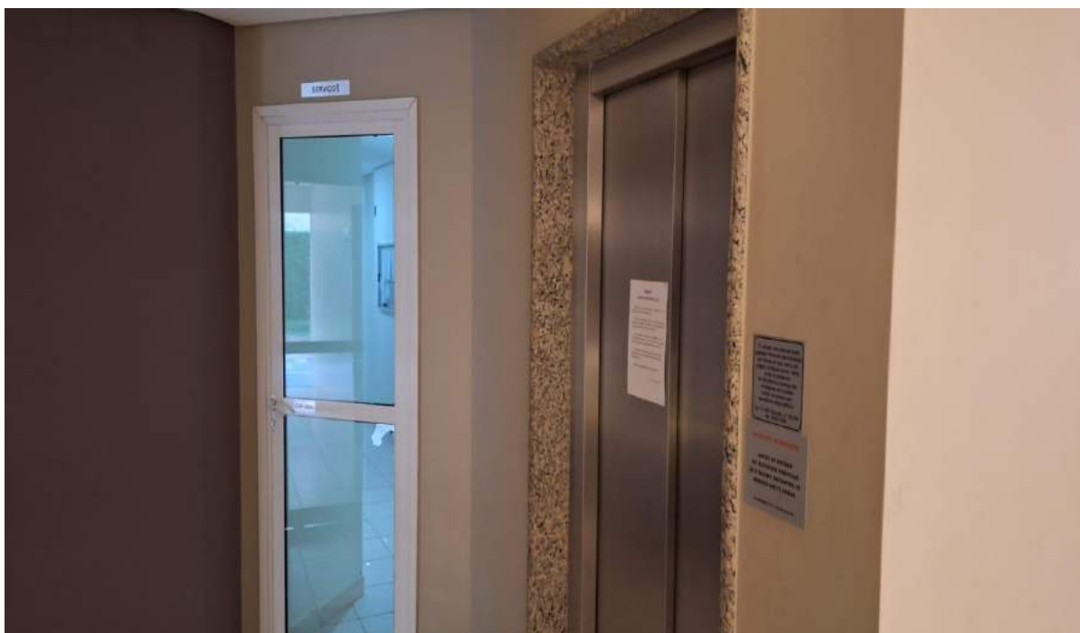
Foto 11 – Hall do elevador social – Bloco A
