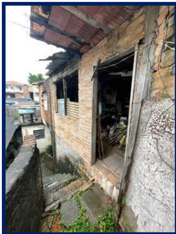
1º subsolo – Depósito: Vista externa.
