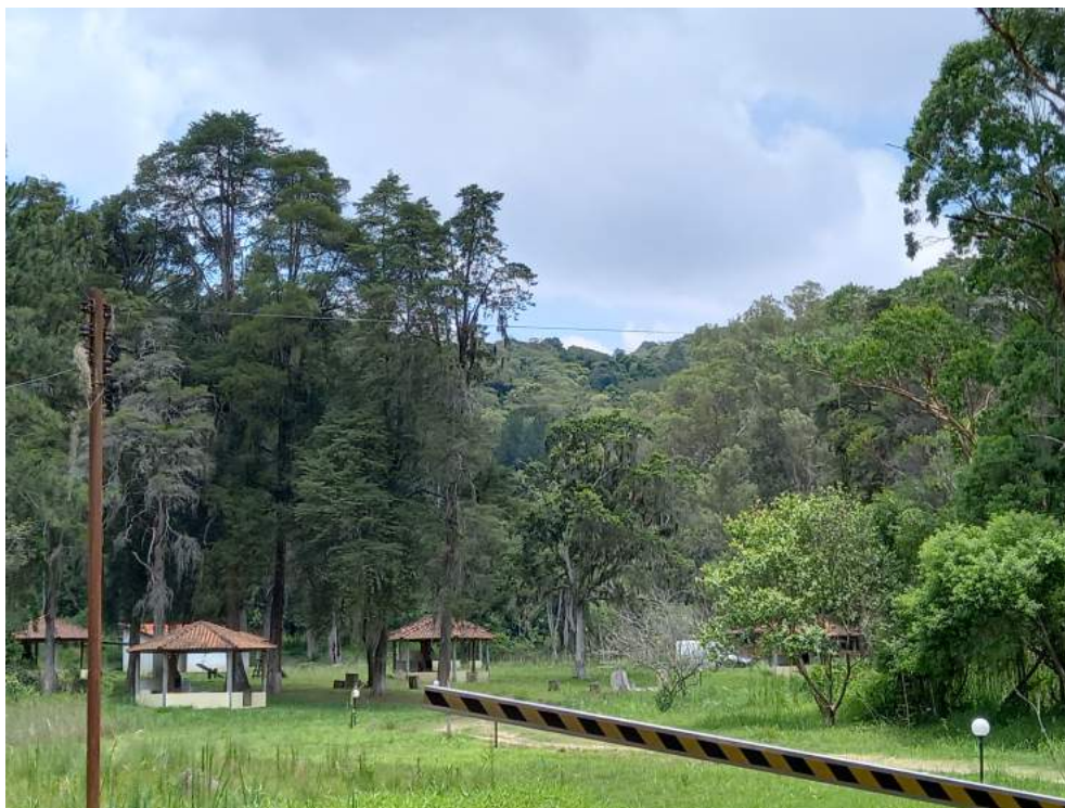
Área Interna – Edificações – Lazer Abrigos
