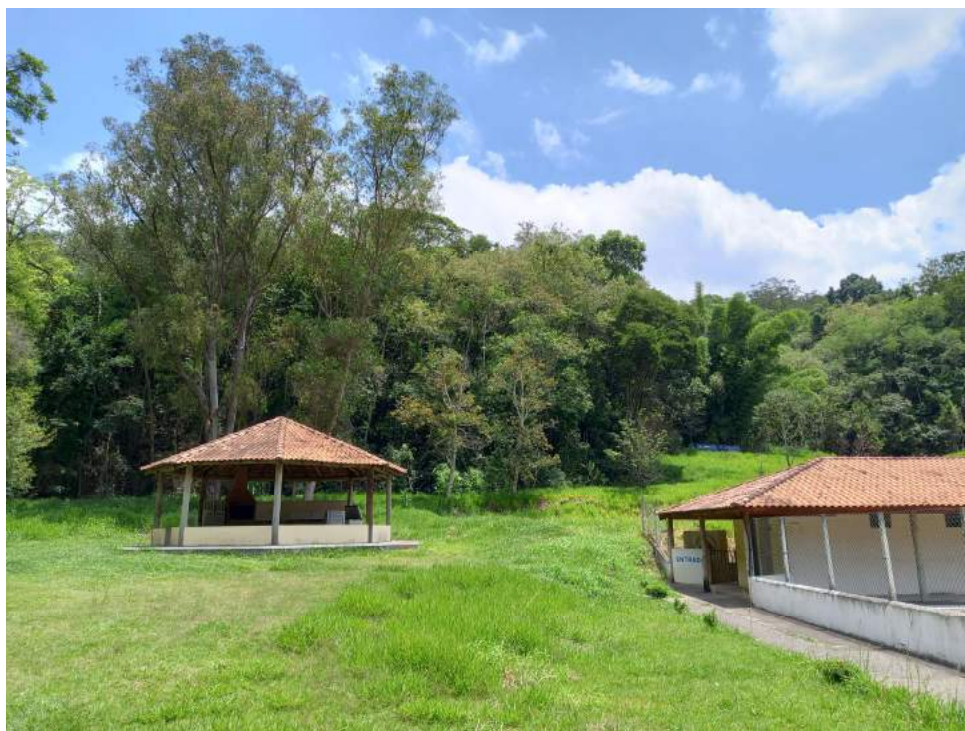
Área Interna – Edificação – Lazer Abrigos
