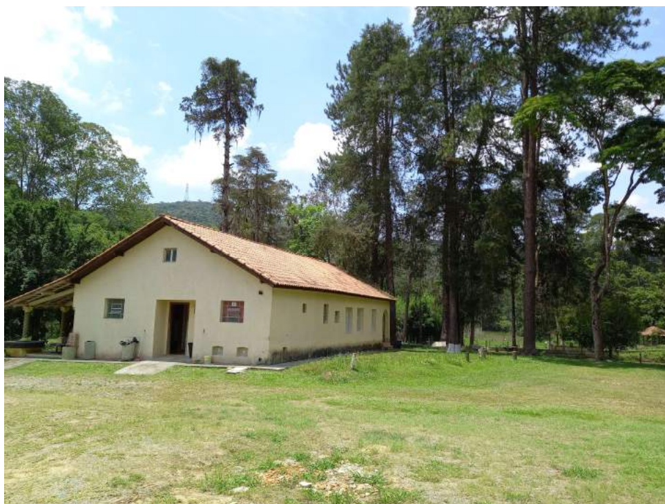
Área Interna – Edificação - Sede
