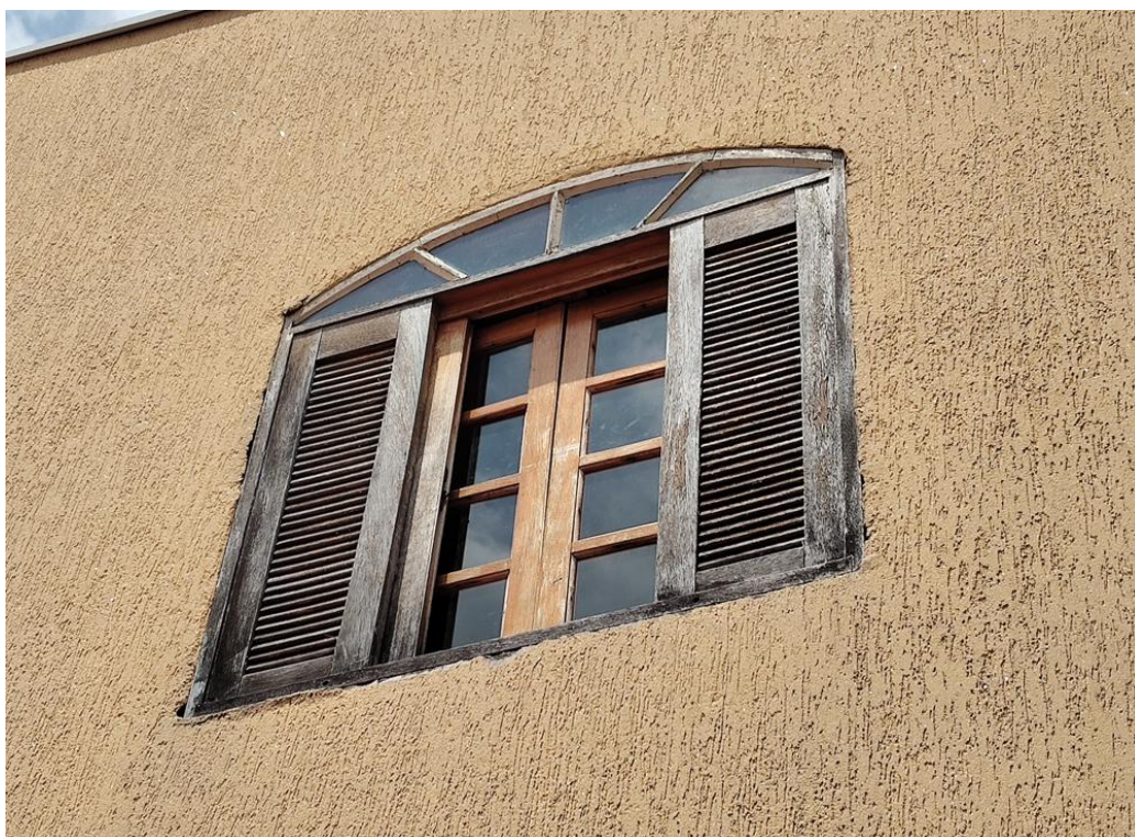
Janela de madeira do piso superior
