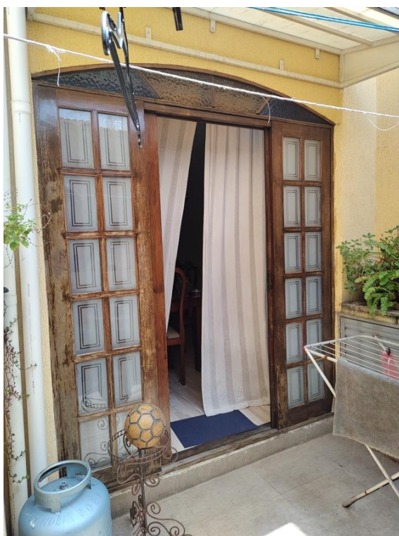
Porta de madeira entre sala de estar/jantar e quintal
