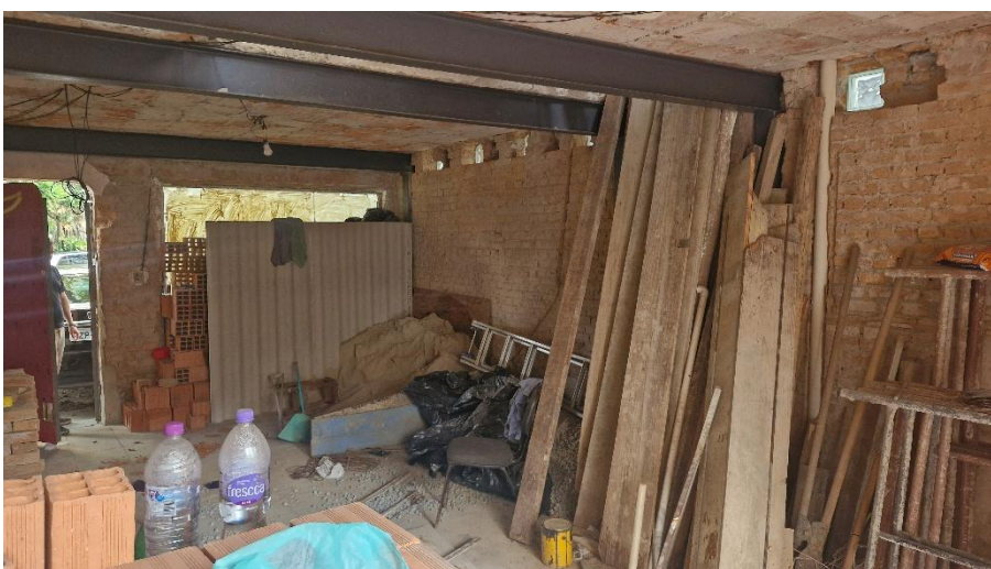
Foto da parte interna do pavimento térreo.
