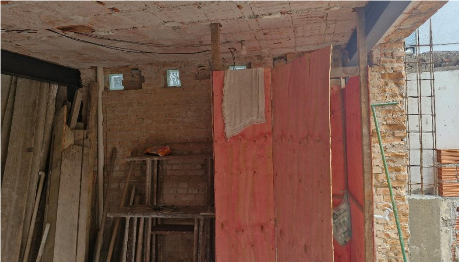
Foto da parte interna do pavimento térreo.
