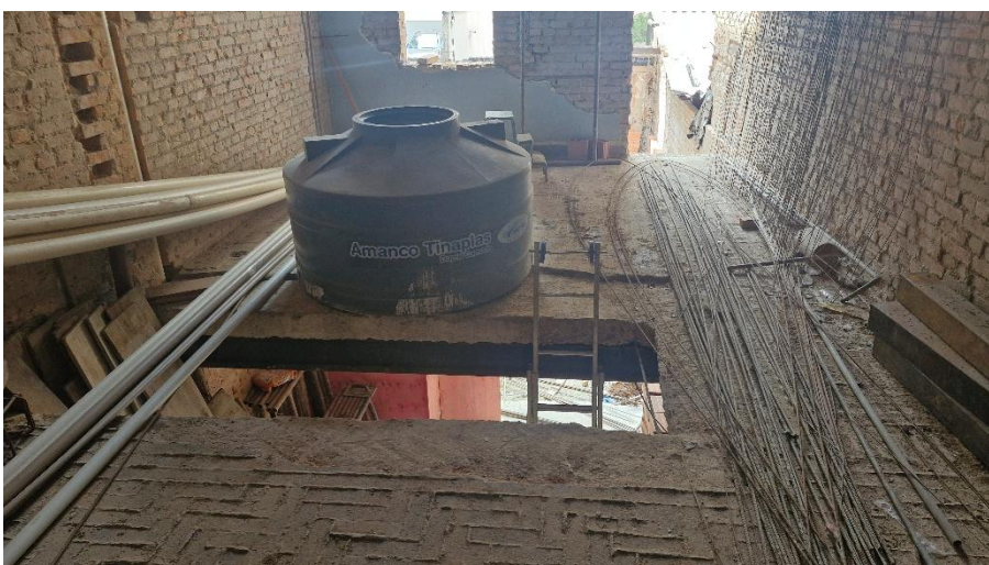
Foto da parte interna do pavimento superior, vão para instalação de futura escada.
