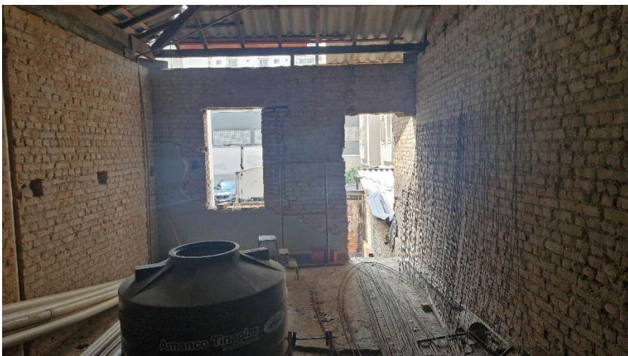
Foto da parte interna do pavimento superior.
