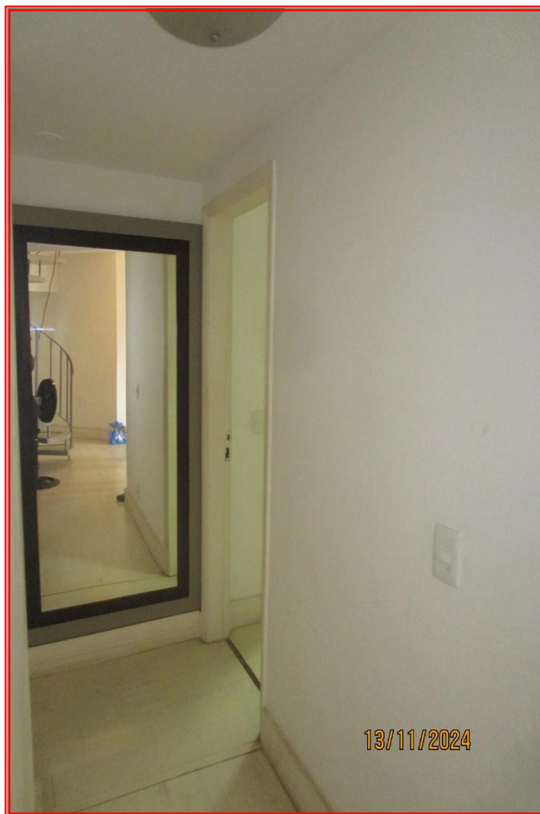
Foto nº 19: Vista parcial do corredor de acesso aos dormitórios.
