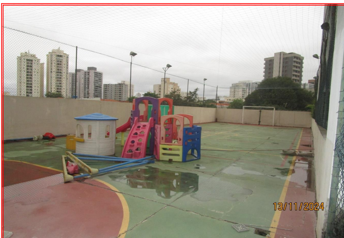
Foto nº 09: Vista geral da quadra poliesportiva.
