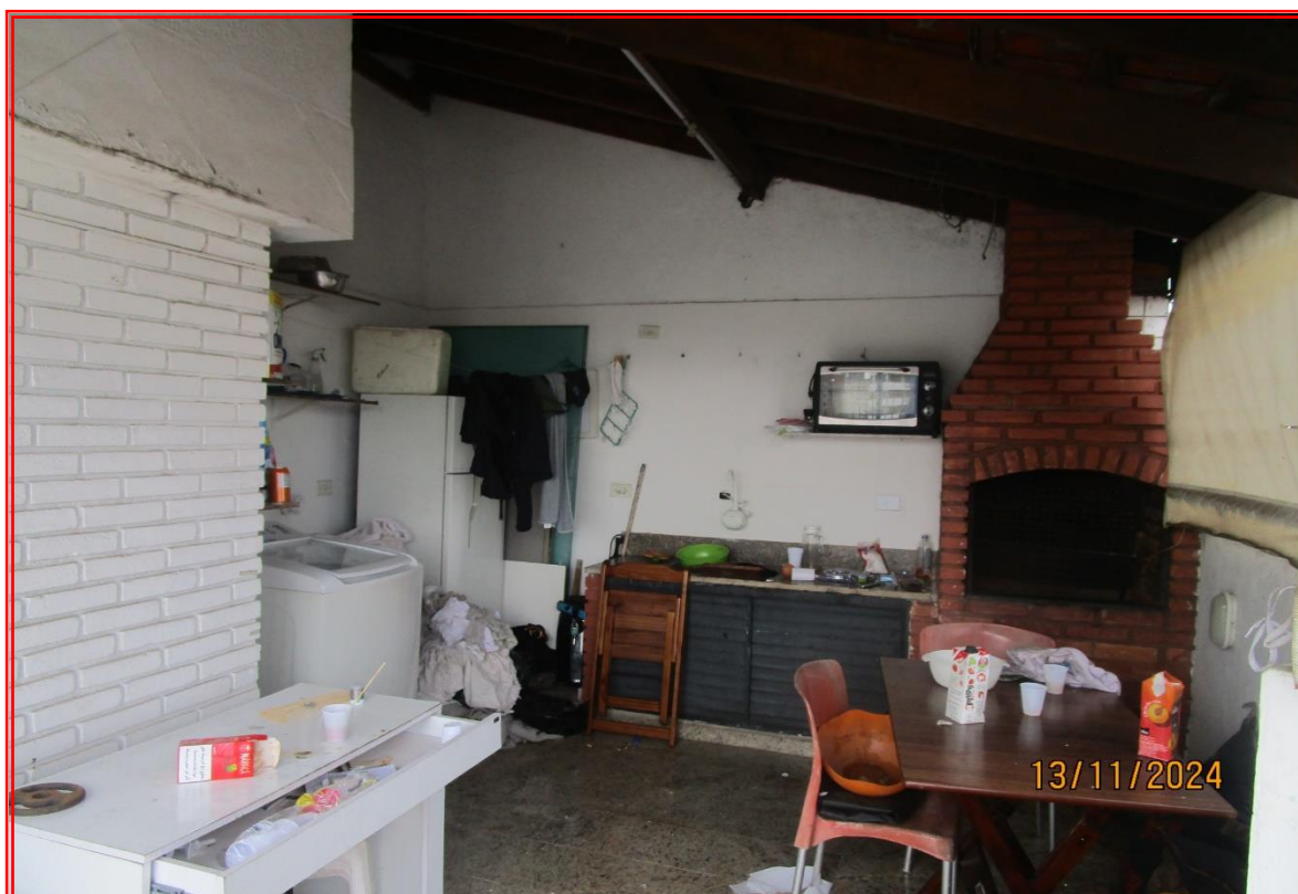
Foto n° 30: Vista parcial da área de churrasqueira da cobertura.
