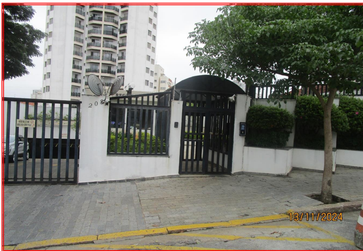
Foto nº 03: Detalhe para a portaria.
