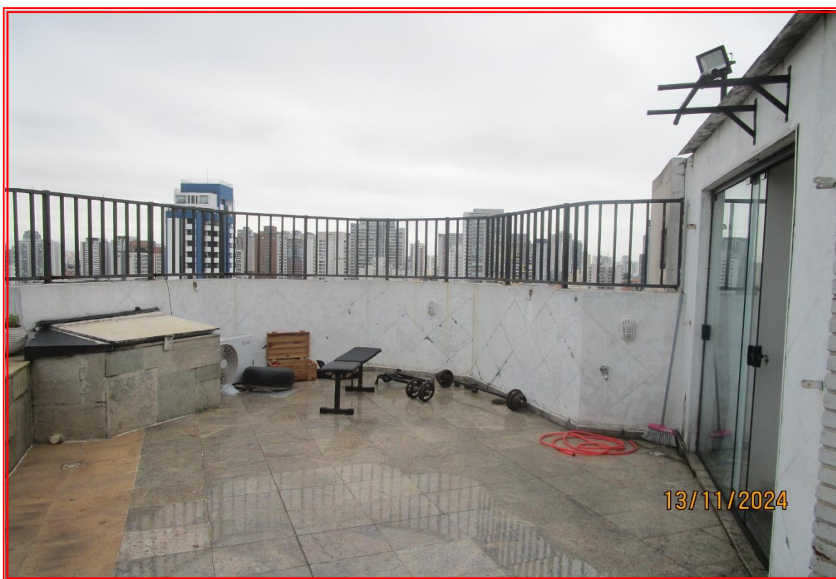
Foto nº 31: Outra vista parcial da área descoberta da cobertura, com detalhe, à direita, para o acesso ao dormitório suíte (antiga sala).
