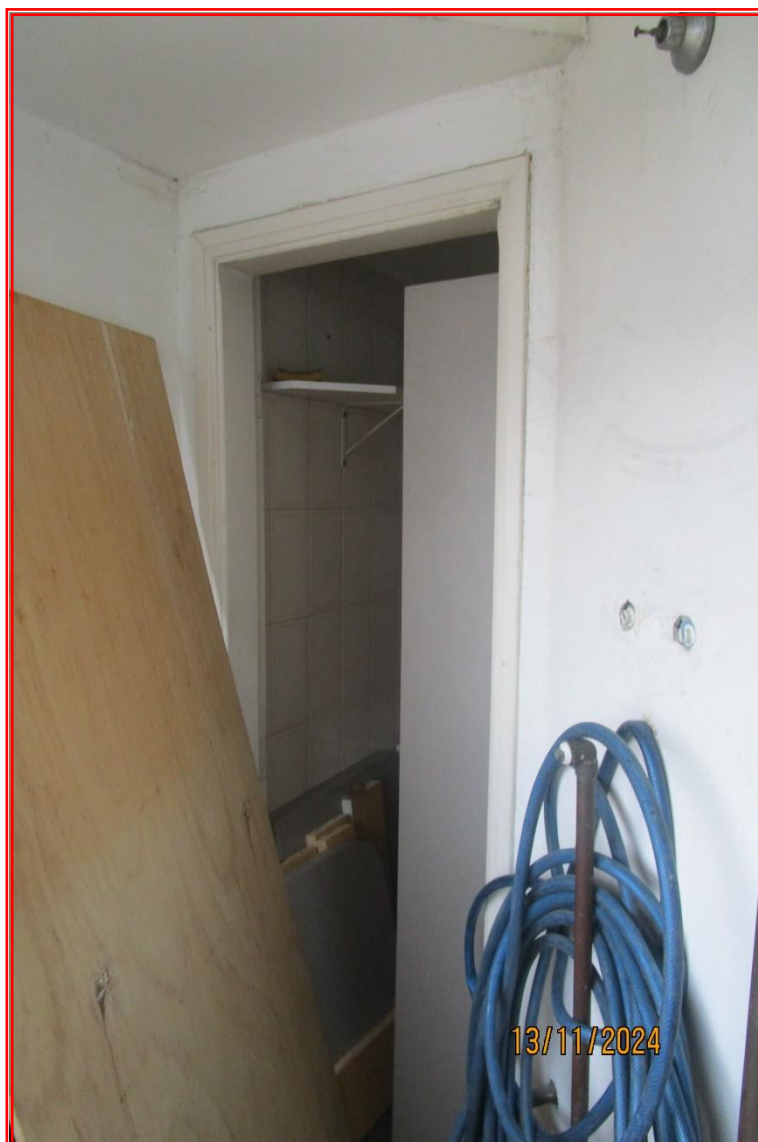
Foto nº 26: Vista parcial da área de serviço e banheiro.
