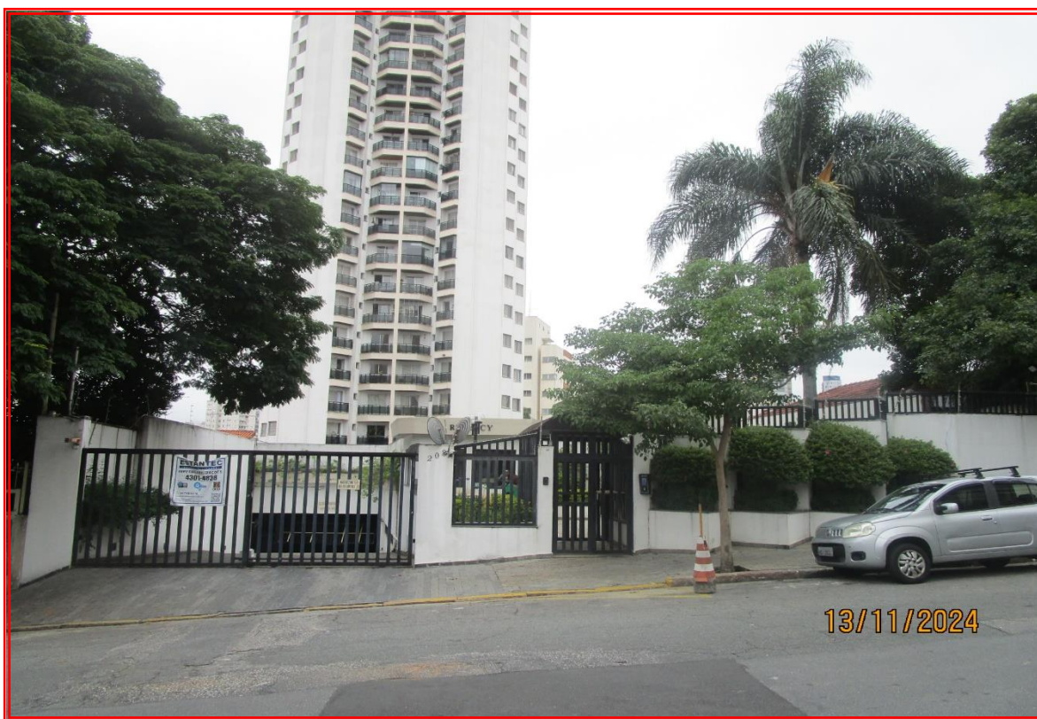
Foto nº 02: Vista geral da rampa de acesso ao subsolo e portaria.
