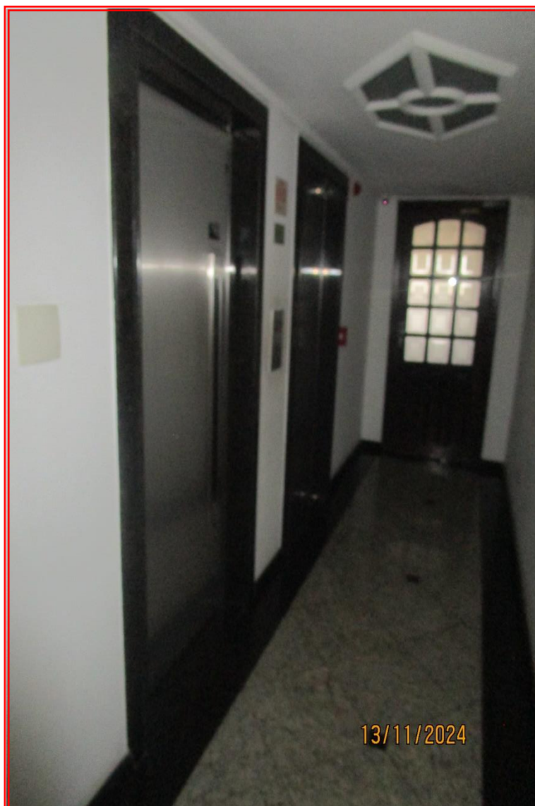
Foto nº 15: Vista parcial do hall de elevadores.
