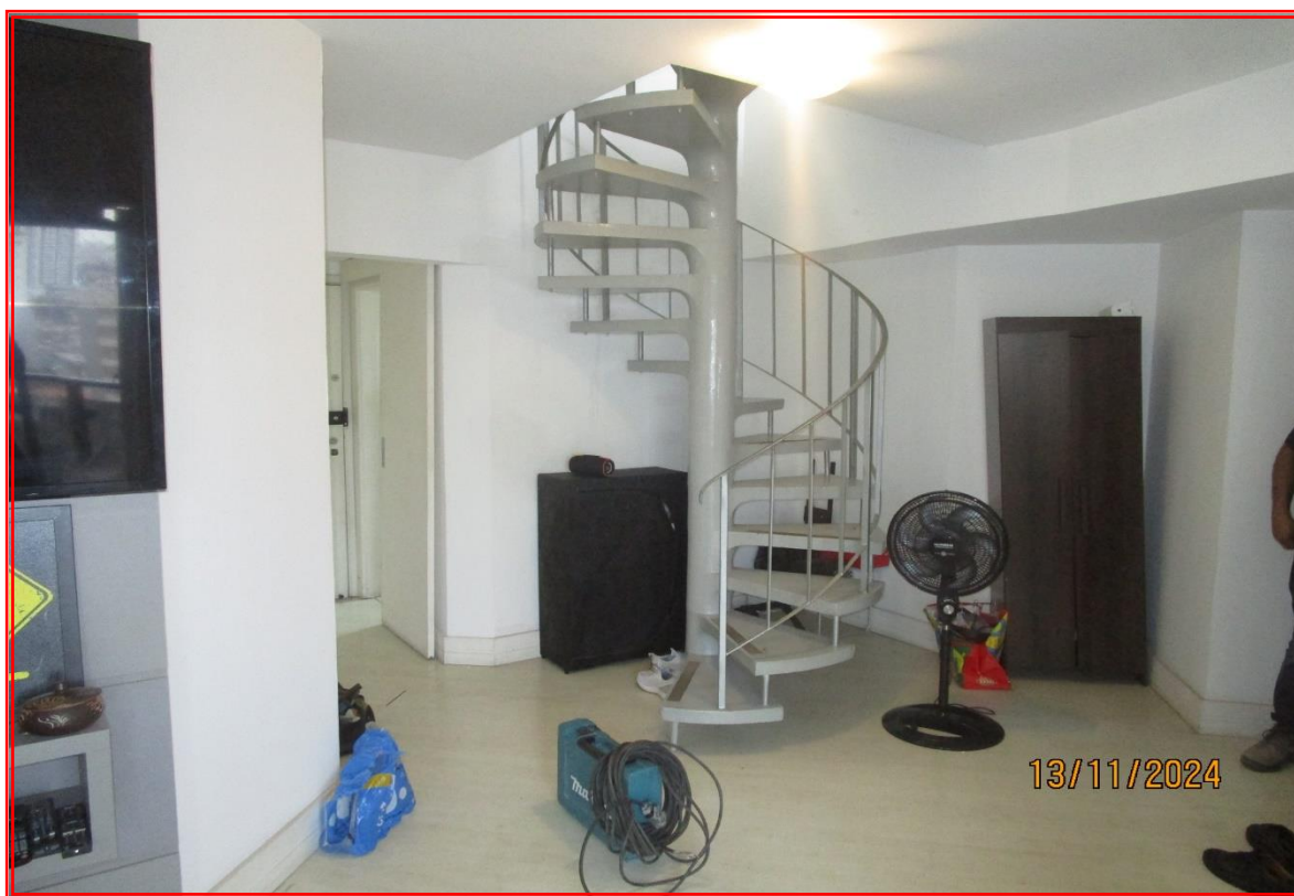
Foto nº 18: Vista parcial da sala do 16º andar.
