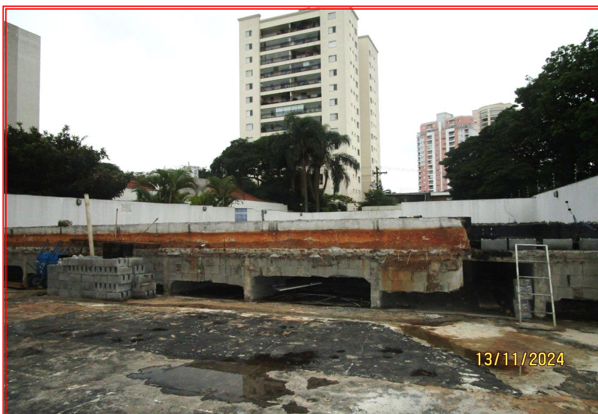
Foto nº 06: Vista da área de piscina em processo de reforma.
