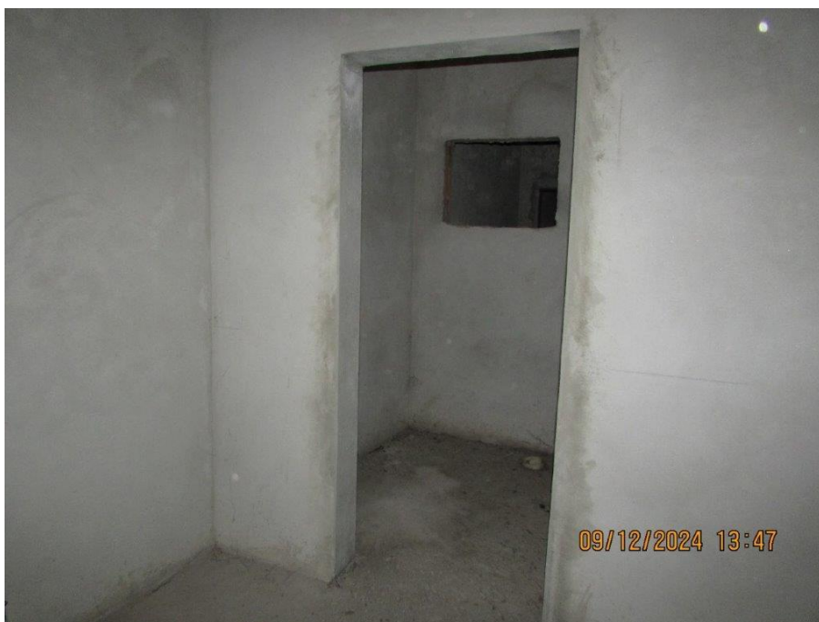
Foto 08: Vista parcial da área de ventilação e iluminação
