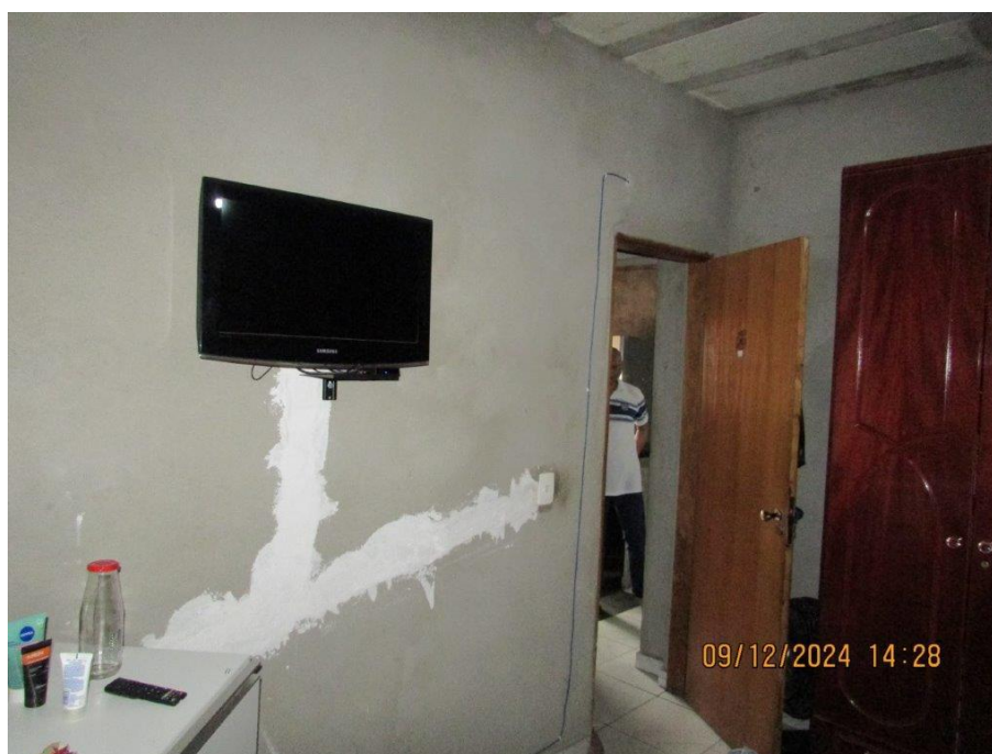
Foto 38: Vista parcial do dormitório 1
