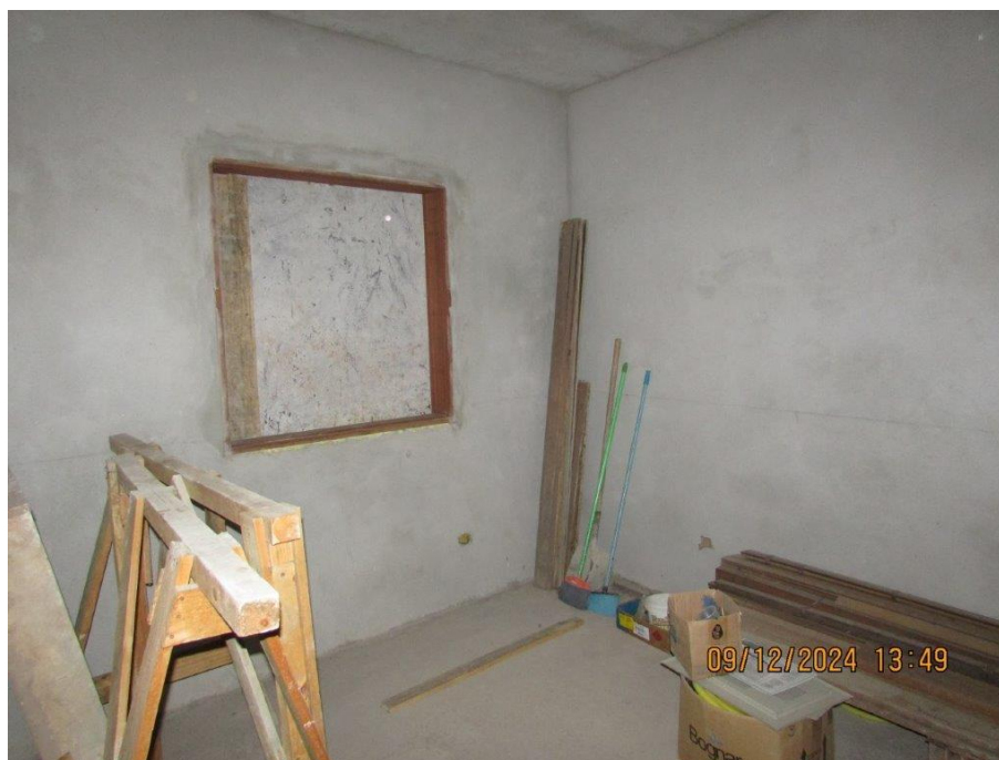
Foto 15: Vista parcial do dormitório
