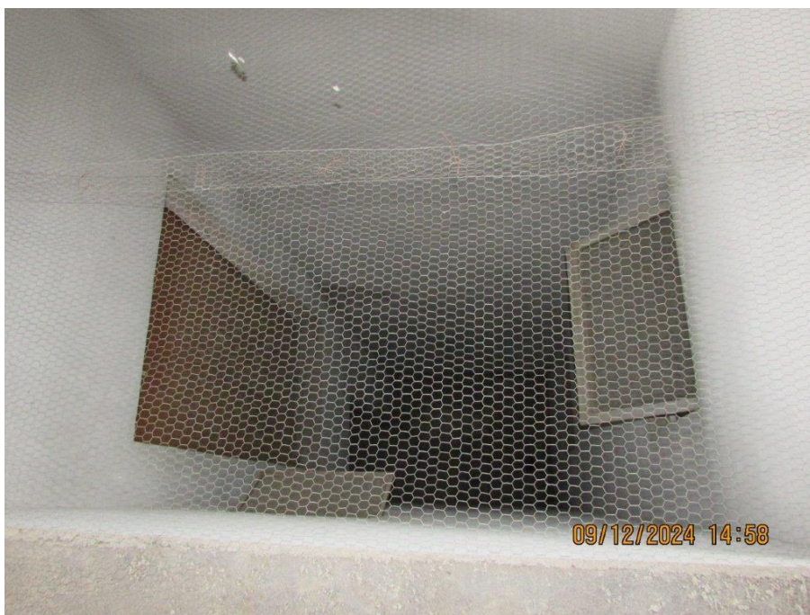
Foto 48: Vista parcial da área de ventilação e iluminação
