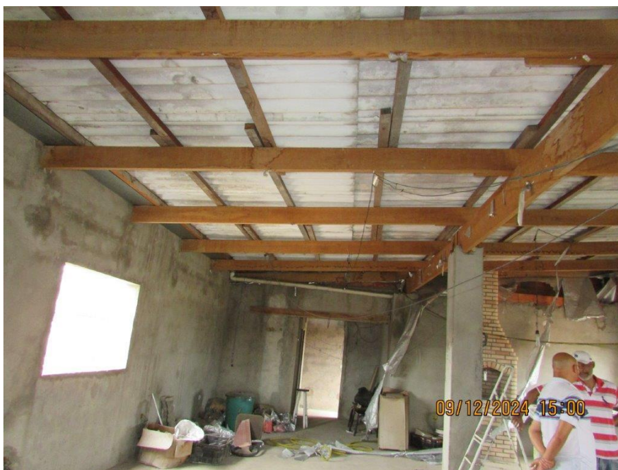
Foto 51: Vista parcial da cobertura
