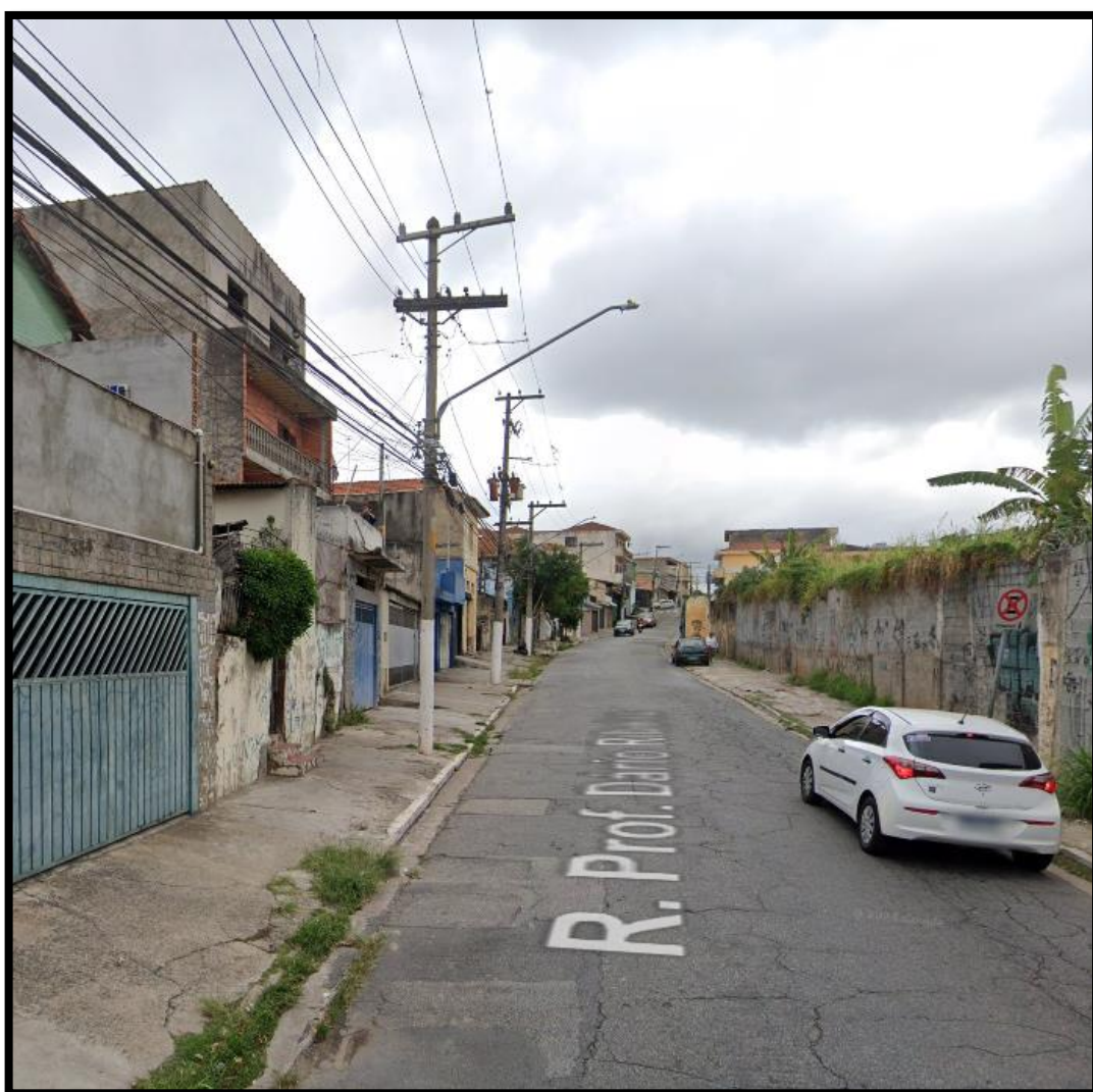
Vista do trecho do imóvel localizado na Rua Professor Dário Ribeiro
