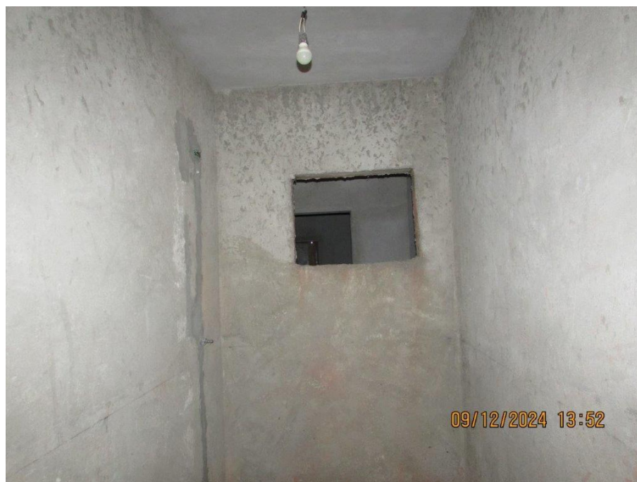
Foto 19: Vista parcial do banheiro da suíte
