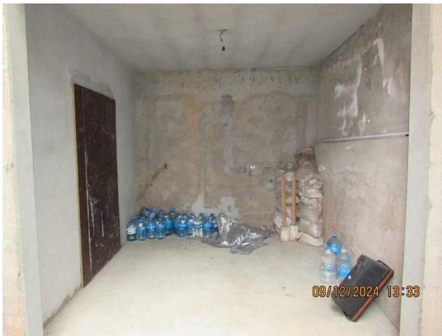
Foto 07: Vista parcial da lavanderia
