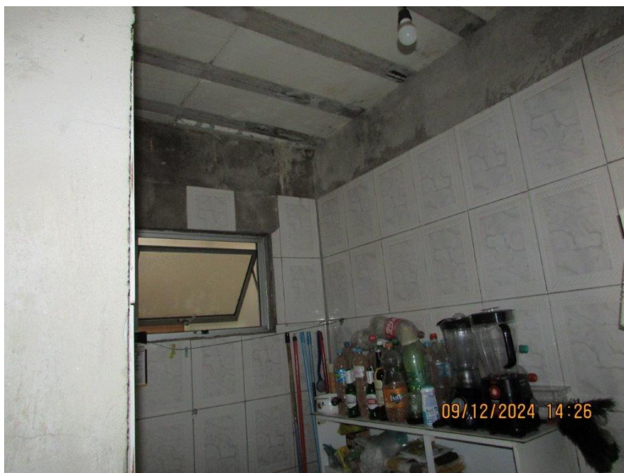
Foto 32: Vista parcial da lavanderia
