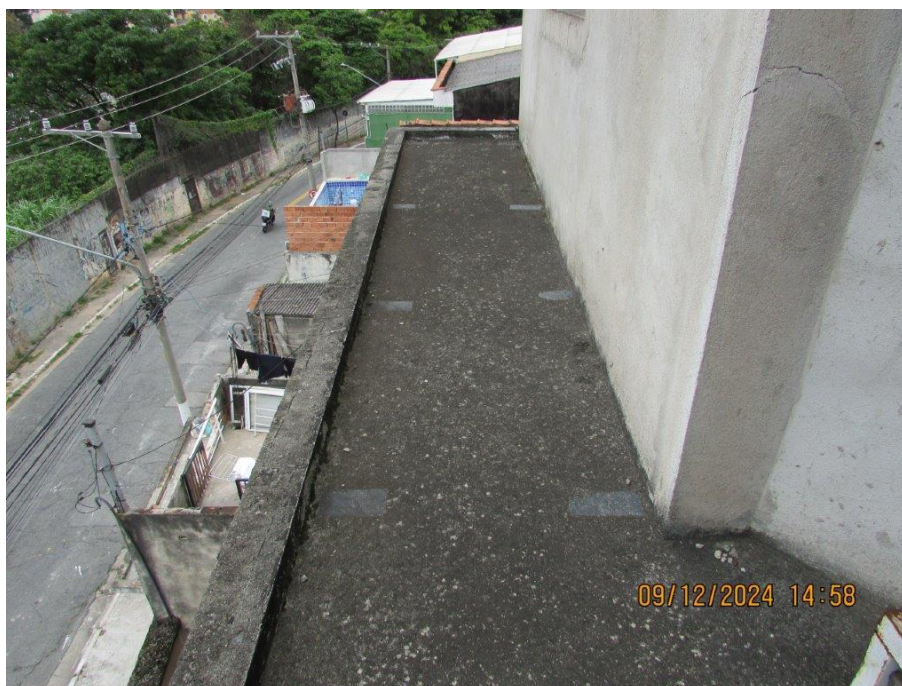
Foto 49: Vista parcial da sacada
