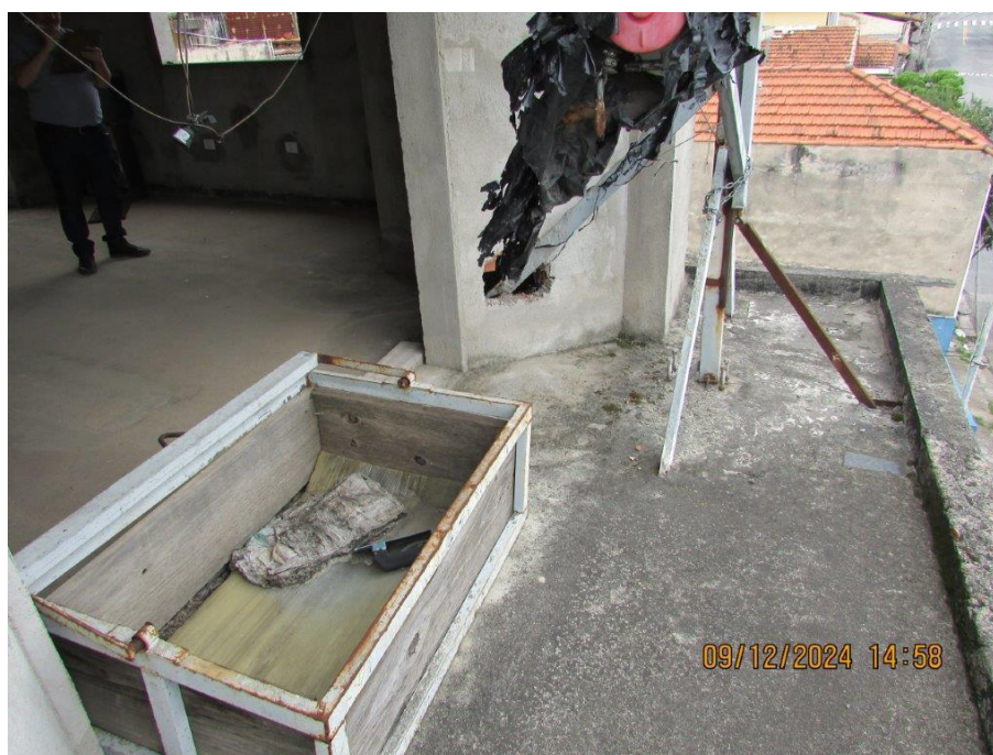
Foto 50: Vista parcial da sacada
