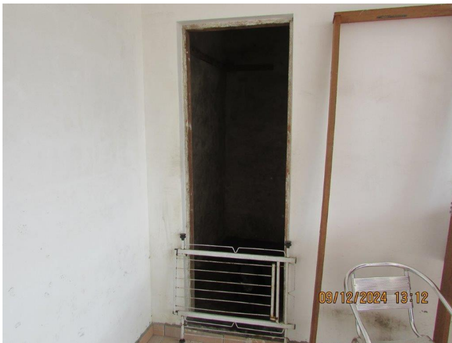
Foto 03: Vista parcial da porta, acesso ao lavabo
