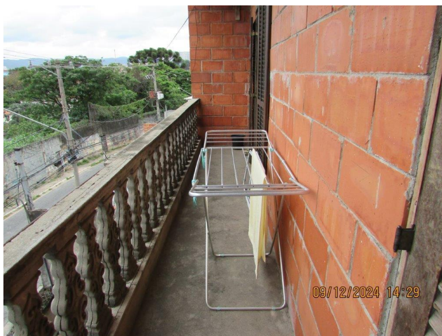
Foto 40: Vista parcial da sacada
