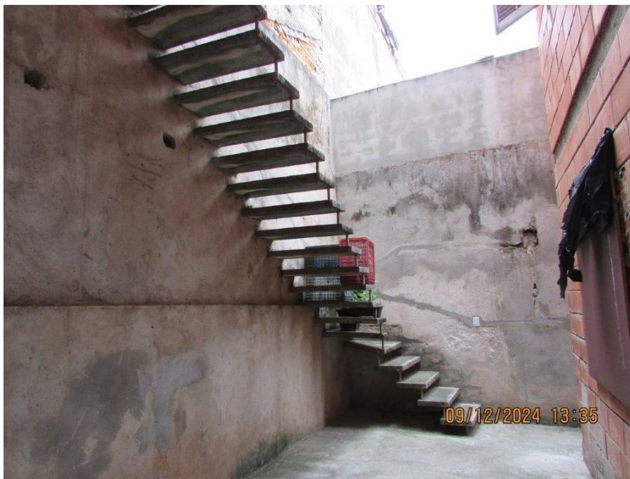
Foto 41: Vista parcial da escada, acesso ao 3º Pavimento
