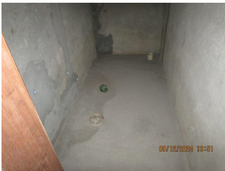
Foto 16: Vista parcial do banheiro social
