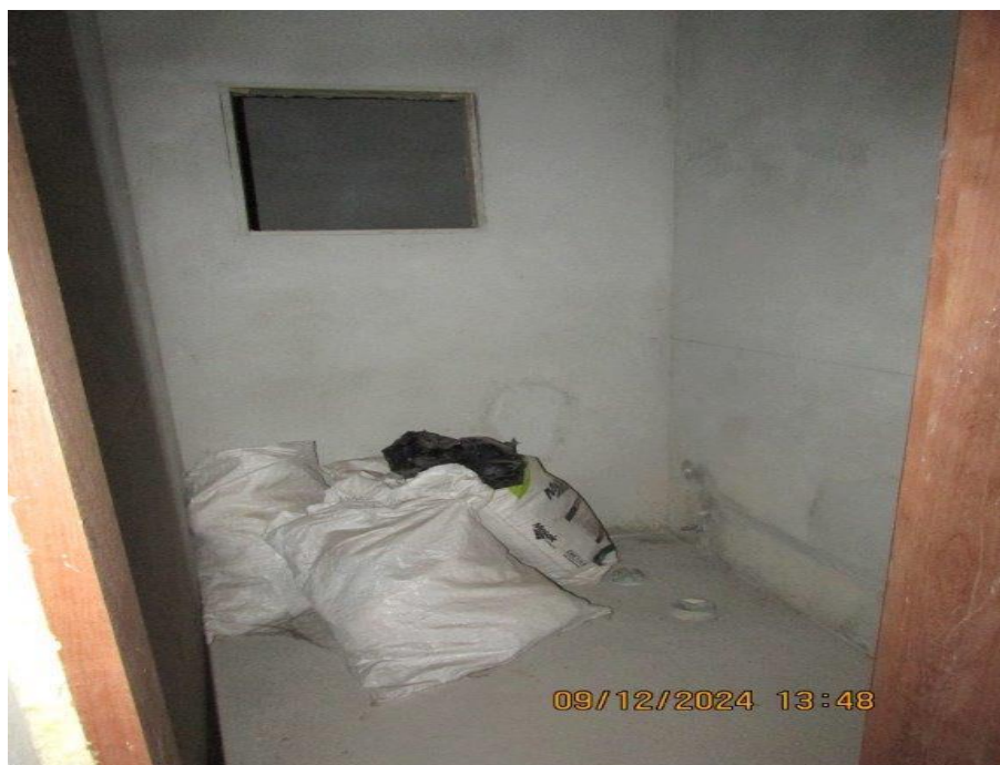
Foto 11: Vista parcial do lavabo
