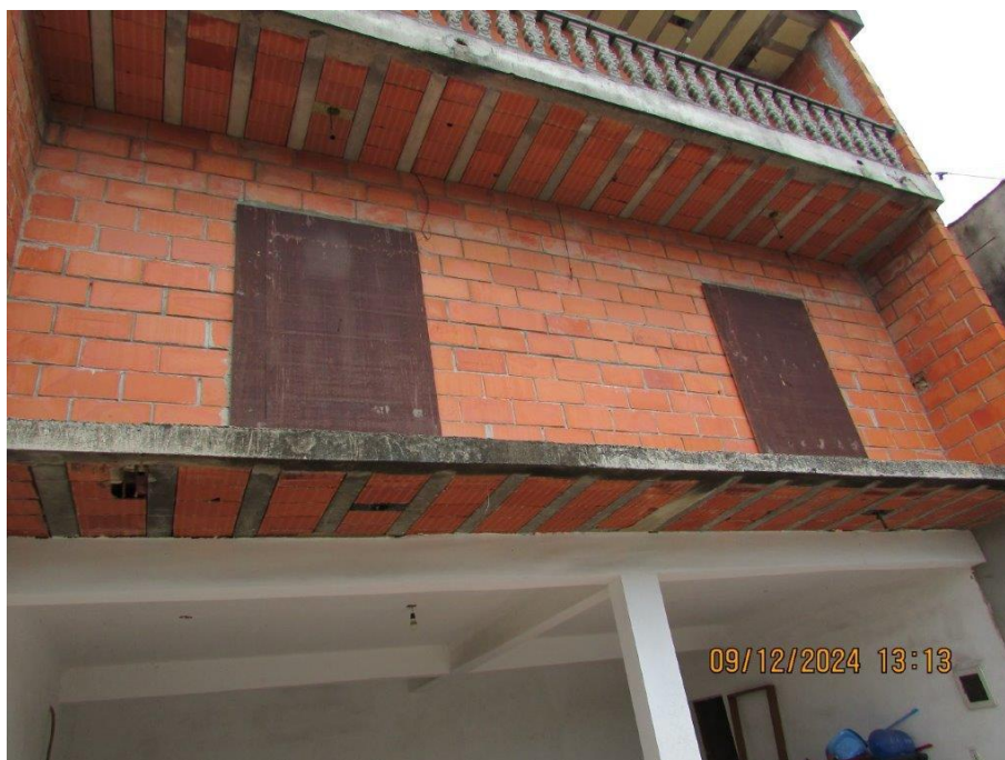
Foto 22 Vista parcial da sacada do 1º Pavimento
