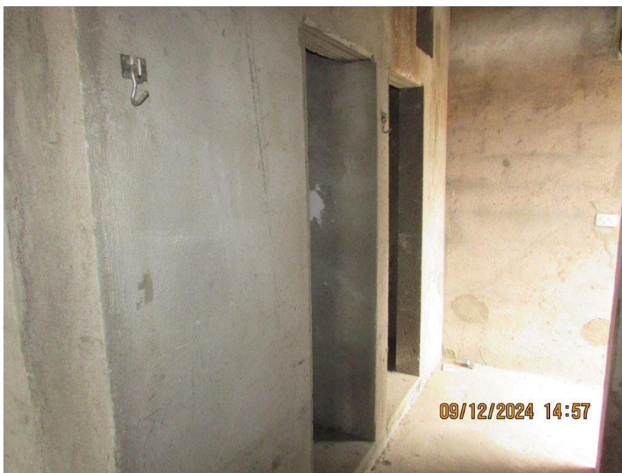
Foto 42: Vista parcial do acesso aos Wcs
