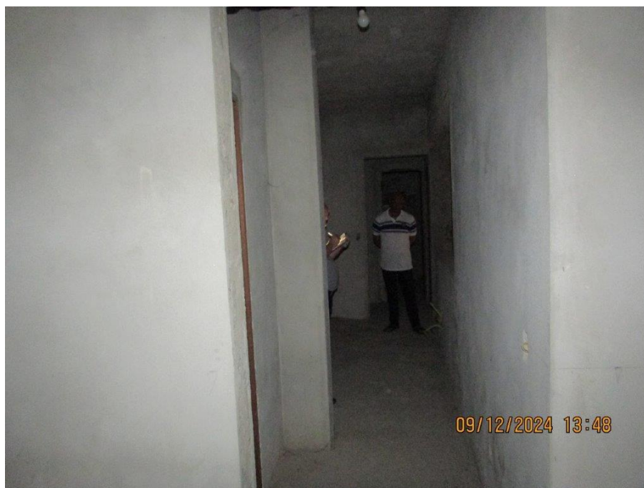
Foto 12: Vista parcial da circulação
