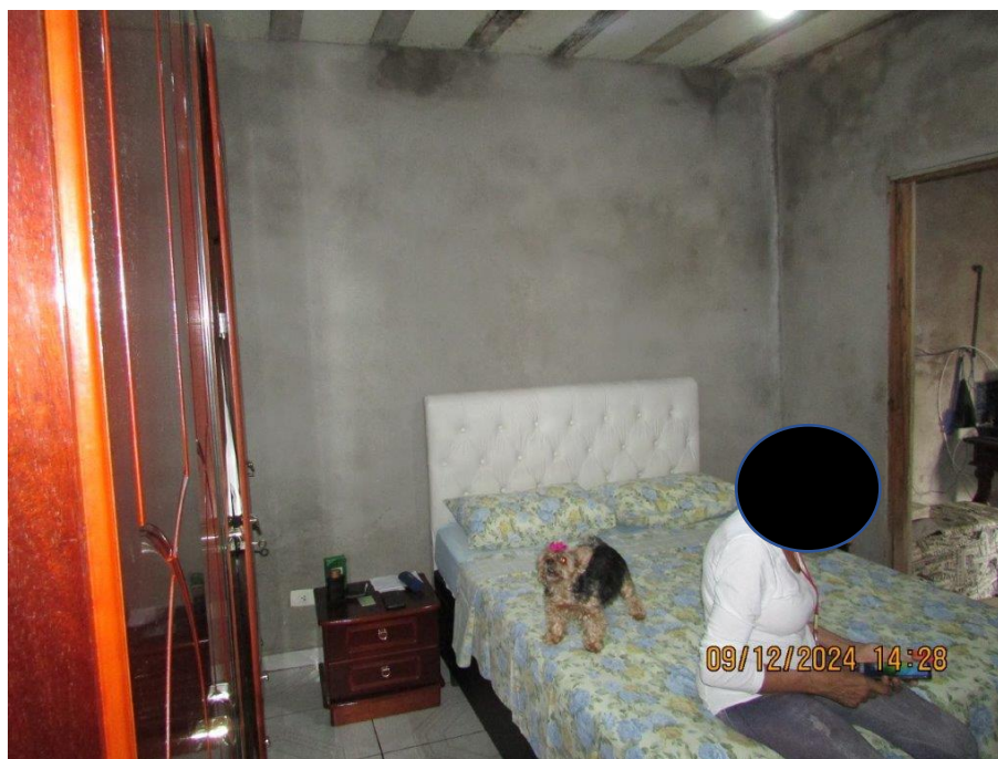
Foto 37: Vista parcial do dormitório 1
