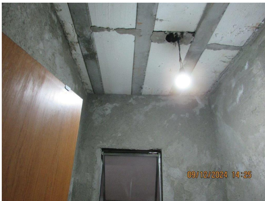
Foto 26: Vista parcial do lavabo
